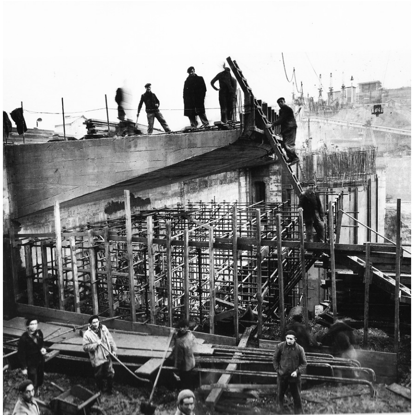
Barrage de Génissiat
