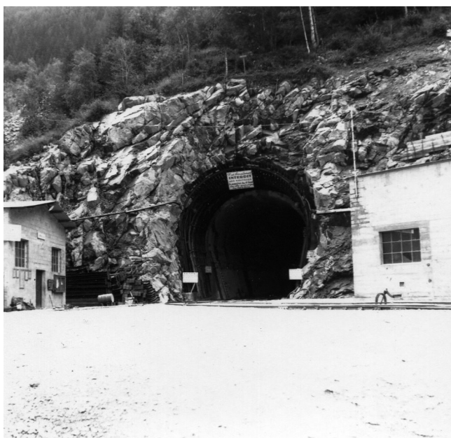
Tunnel du Mont-Blanc
