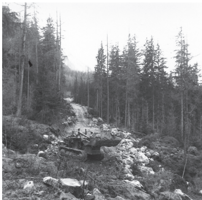
Tunnel du Mont-Blanc : avant de creuser, déjà accéder...
